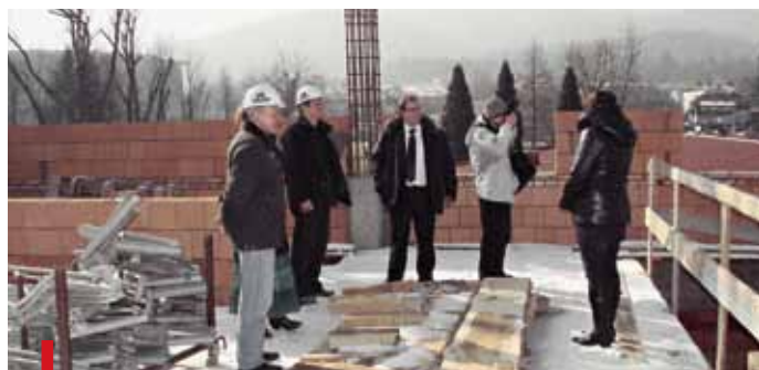
Władze ATH i zaproszeni goście na terenie budowy nowego gmachu uczelni, który zostanie ukończony w przyszłym roku
