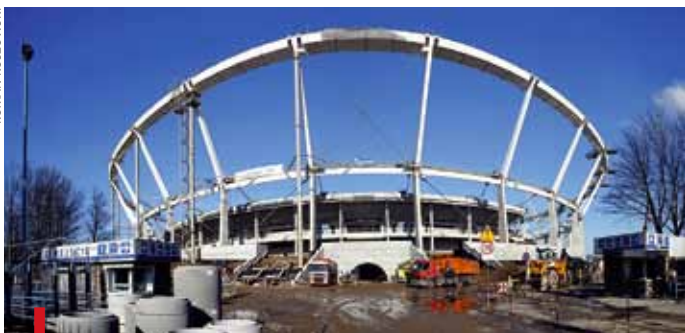
Na stalowej konstrukcji opierać się będzie największy w Europie dach przykrywający obiekt sportowy
