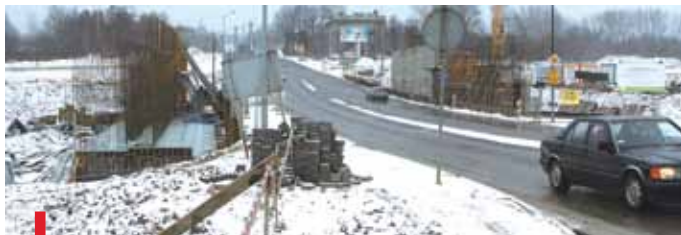
Styczeń 2011. Budowa autostrady A1 na odcinku Pyrzowice–Piekary Śl.
