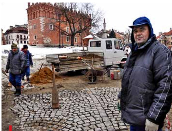
Dziura na rynku została już wypełniona mieszanką cementu i lessu
