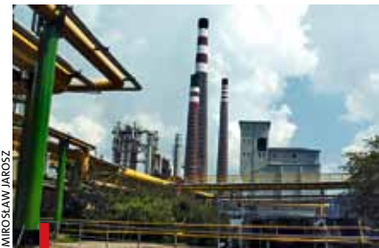
Koksownia Victoria jest jedyną pozostałością zagłębia węglowego
