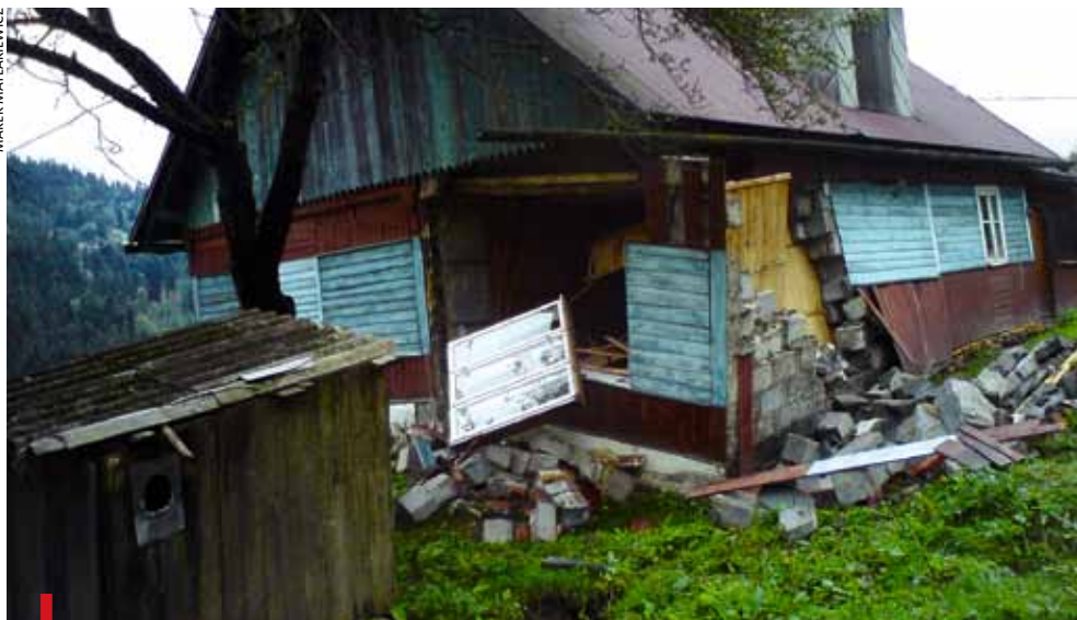
5 WRZEŚNIA, KOLONIA PRUSÓW, GMINA MILÓWKA. Po ulewnych deszczach osuwająca się ziemia zniszczyła trzy budynki
