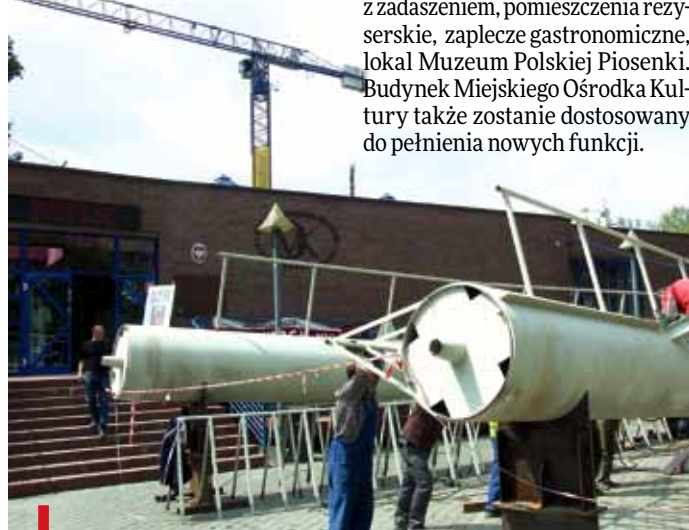
Przebudowa amfiteatru trwa
