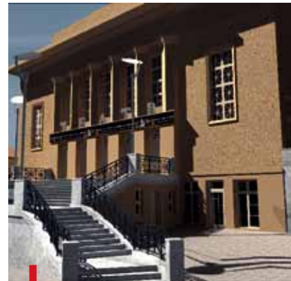
Rewitalizacja obejmuje również remont elewacji budynku
