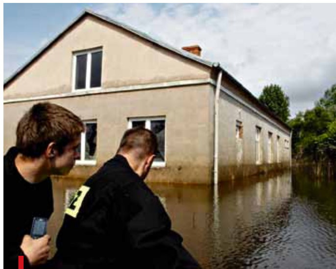
Na zalanych domach dokładnie widać, jaki poziom osiągnęła fala powodziowa
