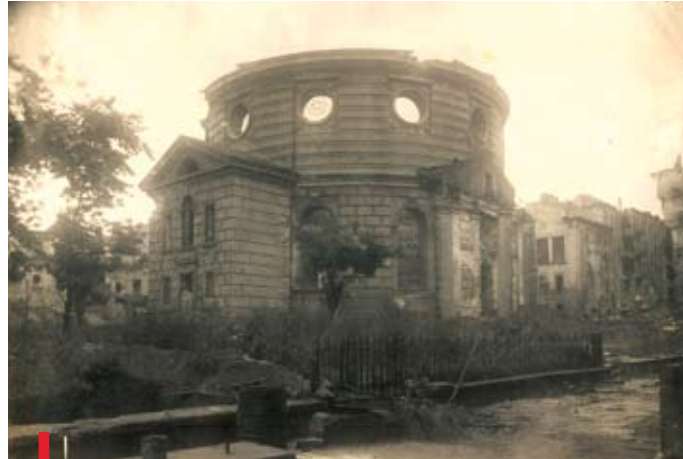
Zniszczony kościół udało się odbudować dzięki wielkiej ofiarności parafian
