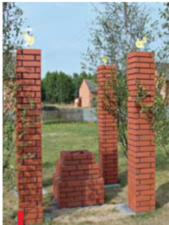
Budowana kapliczka w Kępiu Zaleszańskim
