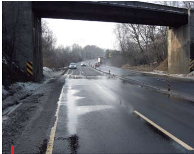
Miejsce dwóch wypadków w jednym dniu
