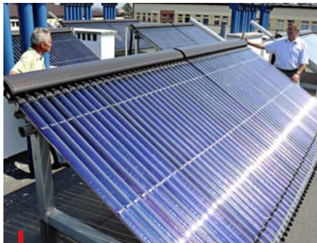
Baterie słoneczne na dachu szpitala zamontowano w celu ogrzewania wody
