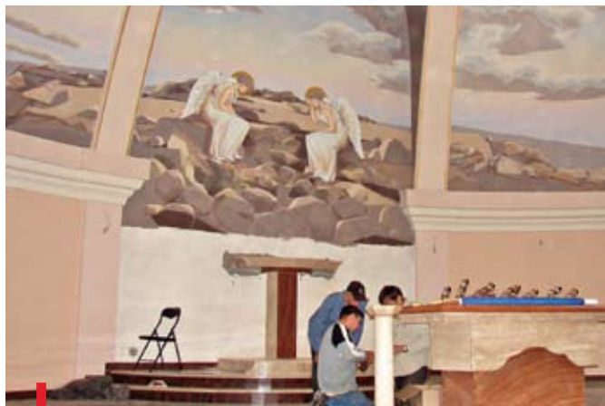
W kościele trwają ostatnie prace wykończeniowe
