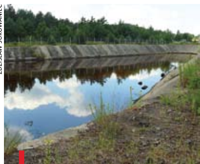
Jeden z sześciu stawów osadowych na terenie huty to uśpiona bomba ekologiczna. Zawartość tego osadnika będzie umieszczona w sarkofagu.
