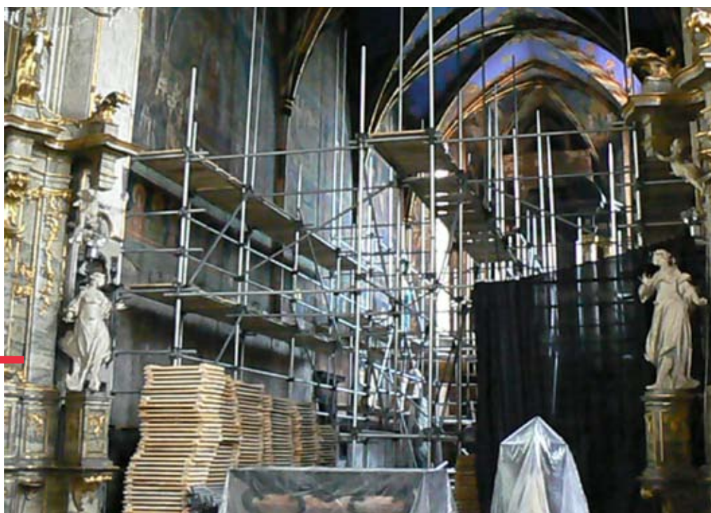
W prezbiterium bazyliki katedralnej w Sandomierzu stanęły już rusztowania
