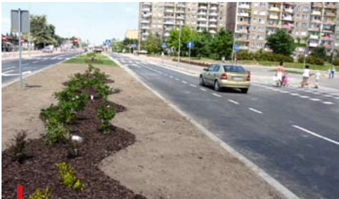
Zmodernizowana ulica Okulickiego wygląda całkowicie inaczej niż jeszcze rok temu
