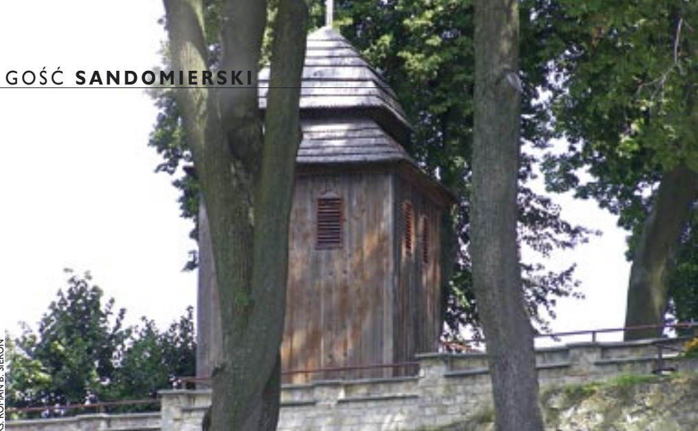
Dzwonnica przy ożarowskim kościele pamiętająca czasy ks. Michała Kuczepeńskiego została ostatnio wyremontowana
