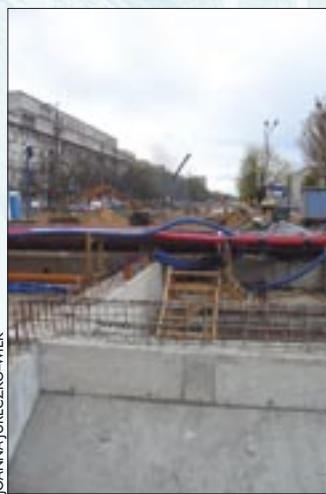
„Odkrywkowa” budowa metra na stacji Stare Bielany
