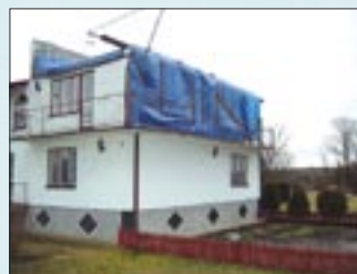
Z tego domu w Przyszowie trąba powietrzna zerwała pół dachu
