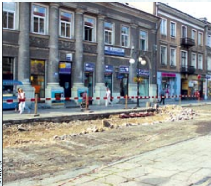
Mimo trwających prac, można wejść do sklepu, a nawet kupić lody
