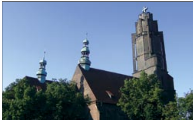
Wysokość wieży do podstawy krzyża liczy 60,5 metra
