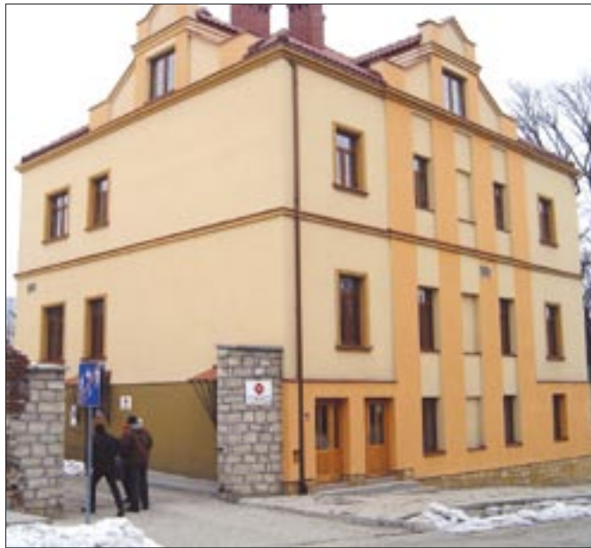
W wyremontowanych budynkach przy ul. Sokolnickiej ośrodek znalazł swój dom
