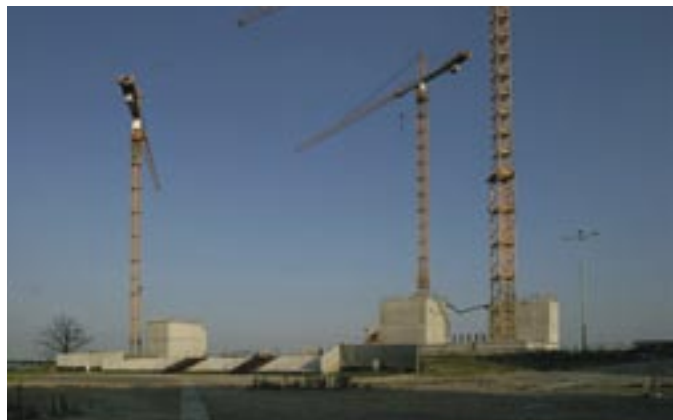
Widok na plac budowy
