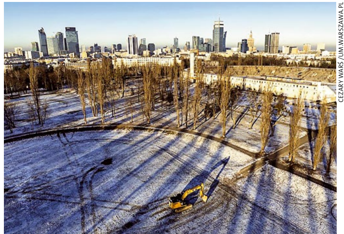
▲ Prace budowlane obejmą 13 hektarów.
