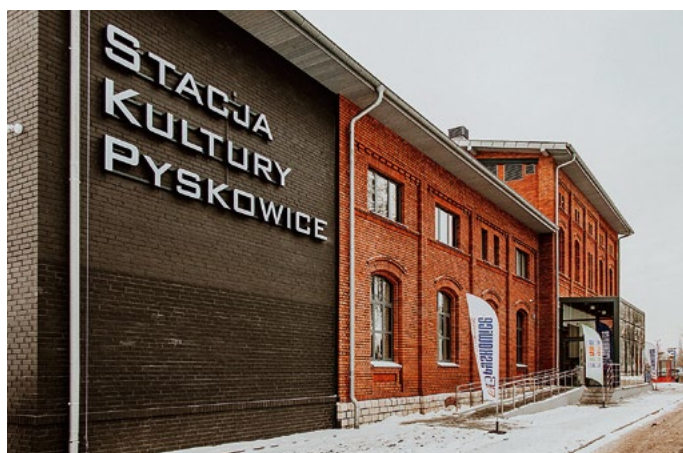
▲ Odrestaurowany i zmodernizowany budynek dworca kolejowego.
