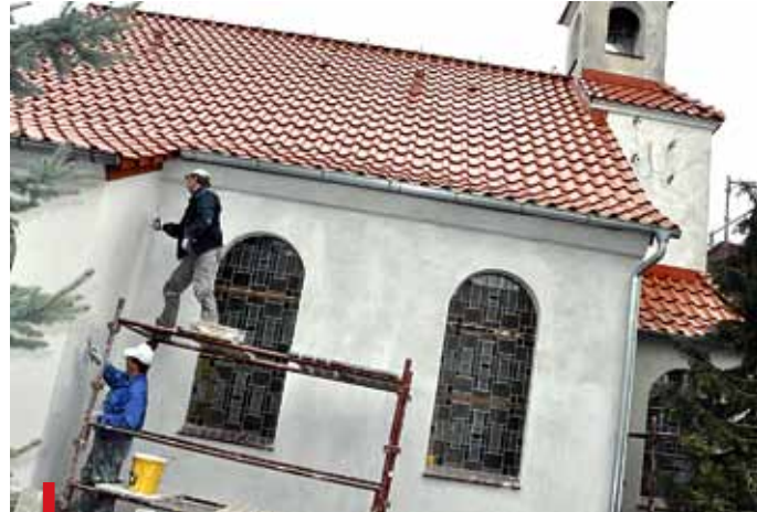
Po wymianie dachu na kościele w Książu Śląskim przyszedł czas na elewację zewnętrzną. Jest to ostatni z czterech remontowanych kościołów w parafii
